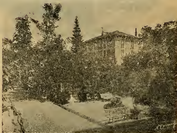
Dipendenza dello Stabilimento
